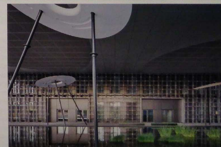
Forum mit den „GuddelVol“-Laternen von Ingo Maurer und einem der Wasserbasins von Michel Desvigne Linke Seite: Fassadendetail im Erdgeschoss
