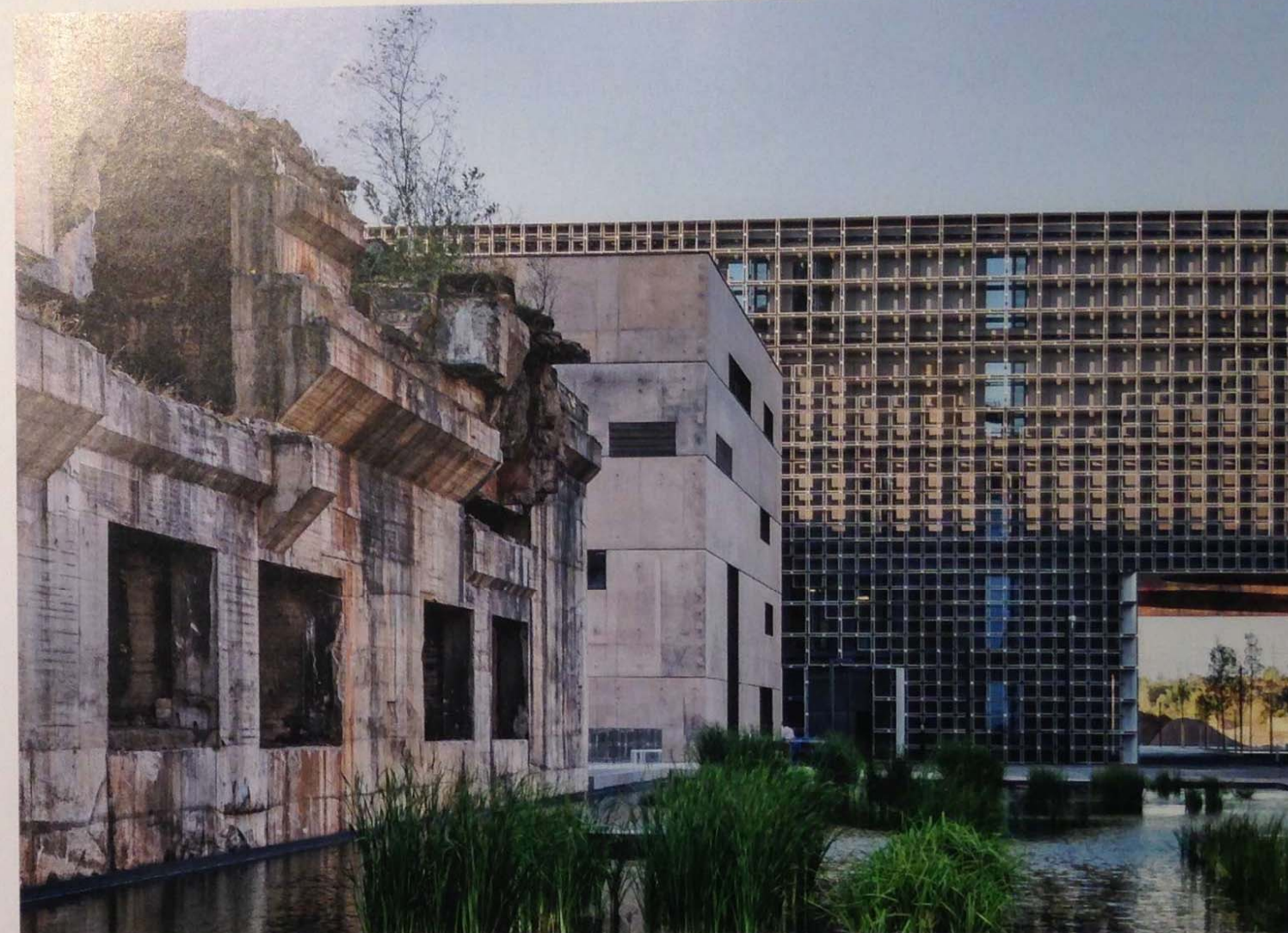
Reste vom Sockel des dritten Hochofens neben dem Sichtbeton-Neubau des Universitäts-Restaurants
