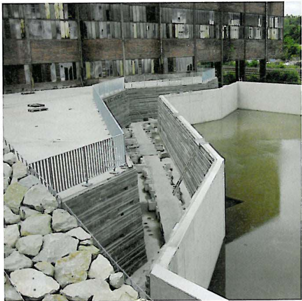
Het geothermiebassin in uitvoering.
