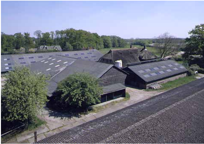
Bijgebouwen hoeve Oud Middachten maken plaats voor kleinschalige erfbebouwing.
