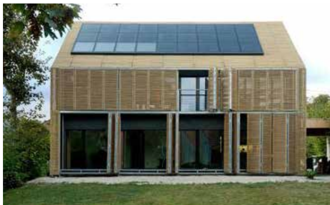
Opwekken energie middels zonnepanelen
