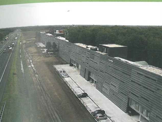
TILBURG-ZUID. GELUIDSWERENDE VOORZIENING VAN ZEVENHONDERD METER LANG EN VEERTIEN METER HOOG. EEN GELUIDSSCHERM VAN IN TOTAAL 170 WONINGEN VAN VERSCHILLENDE OMVANG EN OPZET, MET DE ACHTERKANTEN GEKEERD NAAR EEN DRUKKE SNELWEG.
